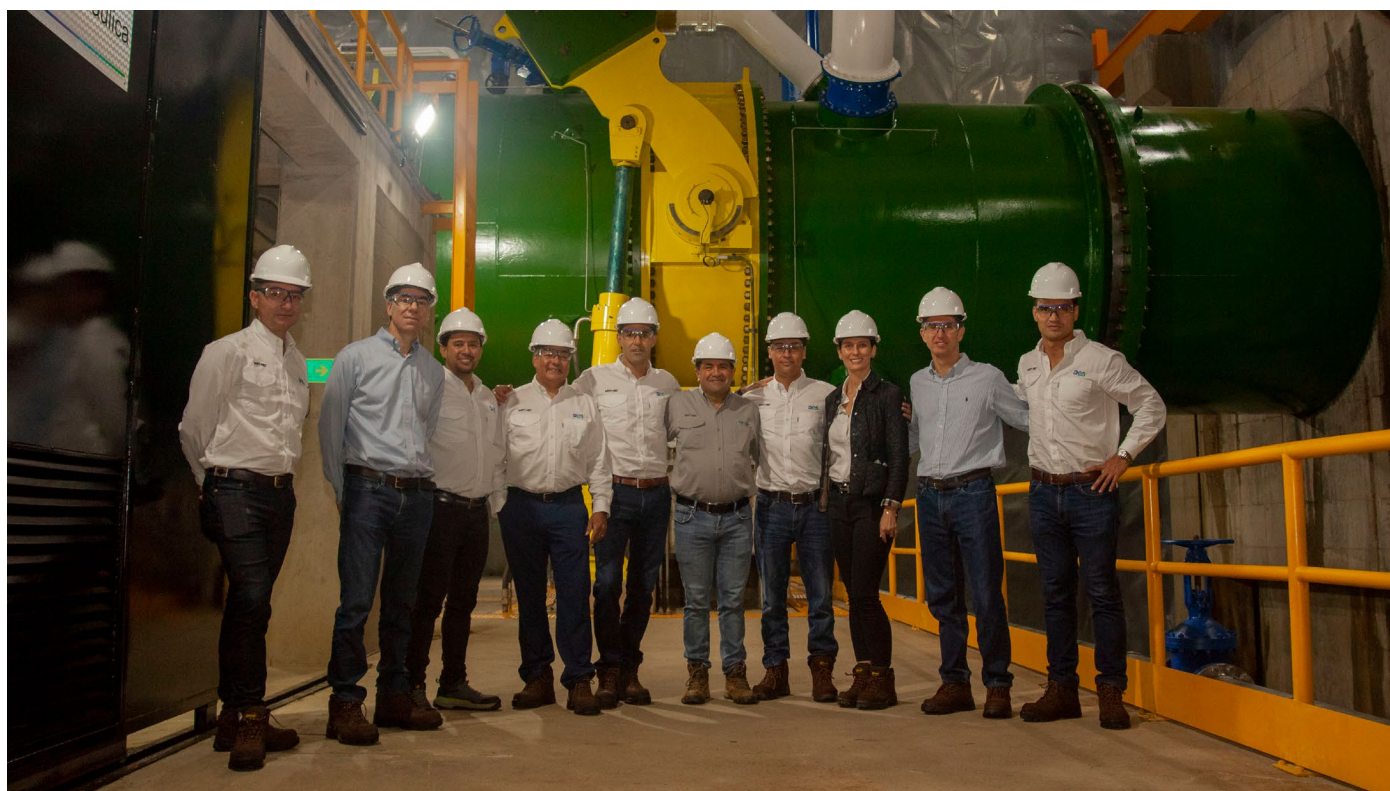
Cámara de válvulas - ramal de conexión 1
