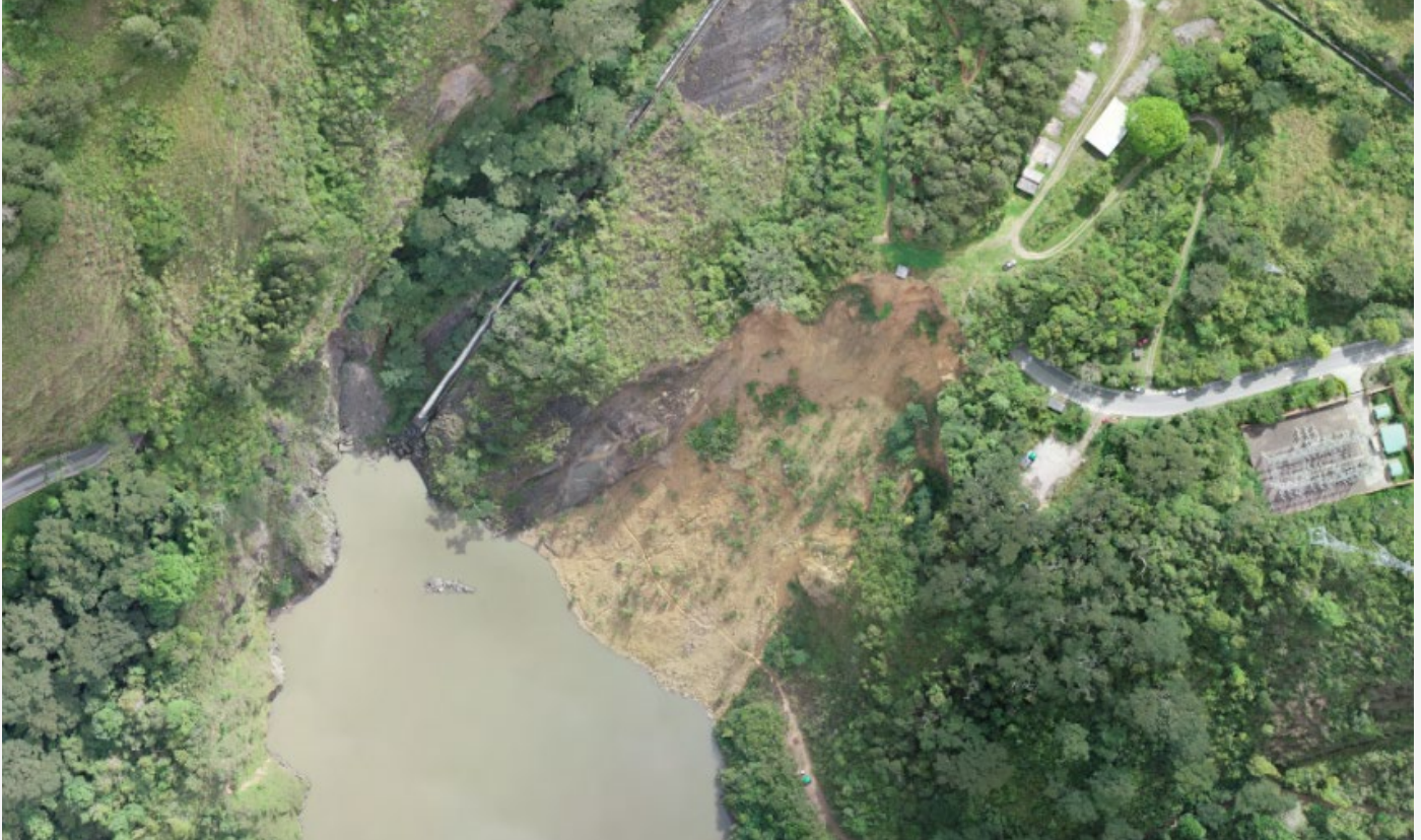
Panorámica del talud Tunjita, sitio 20
