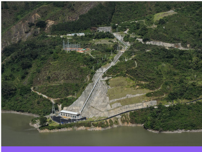
Pequeña Central Hidroeléctrica Tunjita
