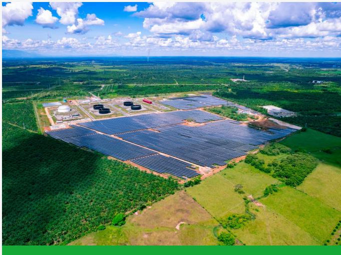
Parque San Fernando Solar
